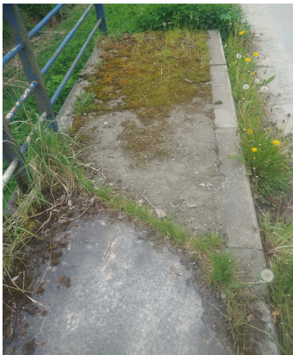
Zdjęcie nr 6: Kapa chodnikowa i krawężnik do demontażu
