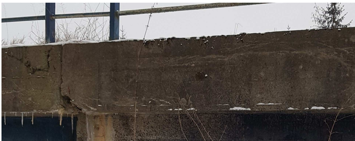
Zdjęcie nr 5: Belka podporęczowa do demontażu
